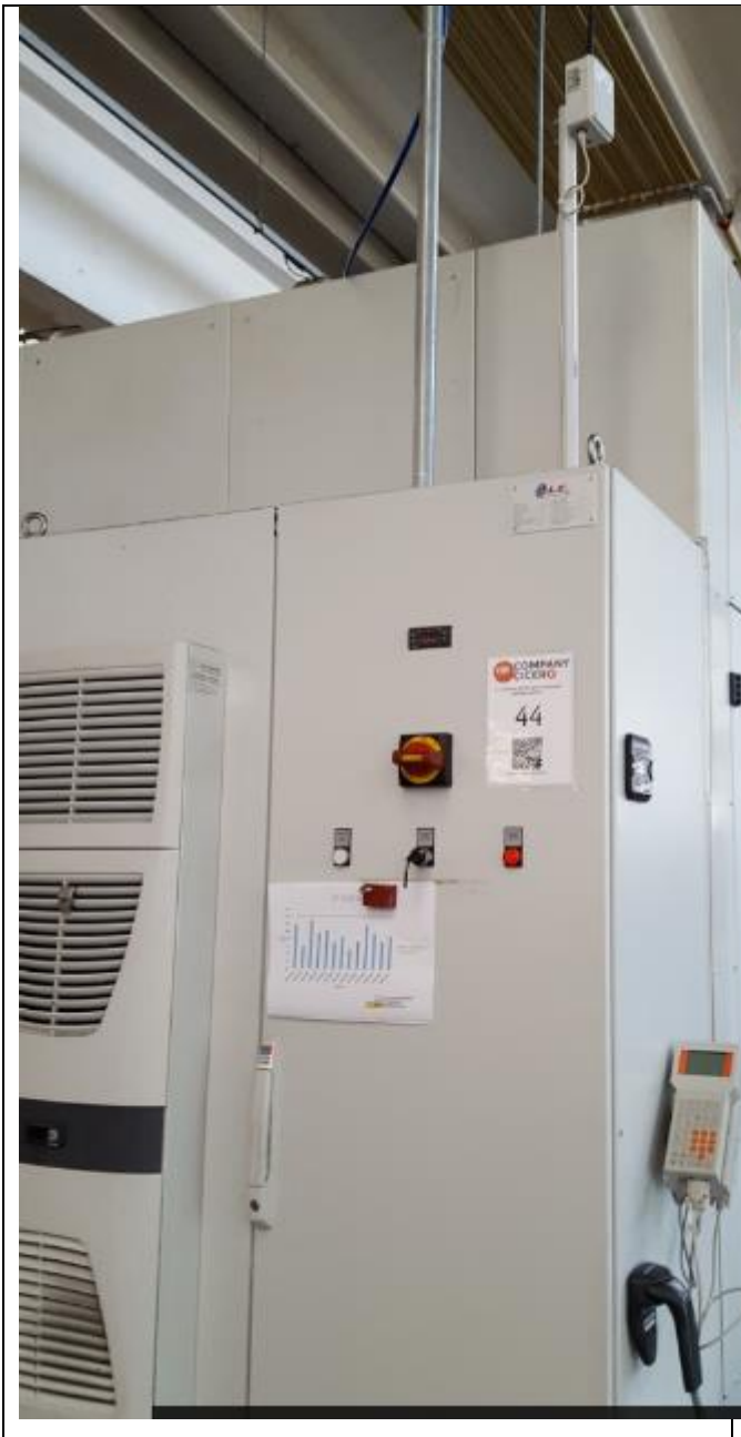
Figura 1 Installazione del bene su un centro di lavoro in cui sono evidenti:
