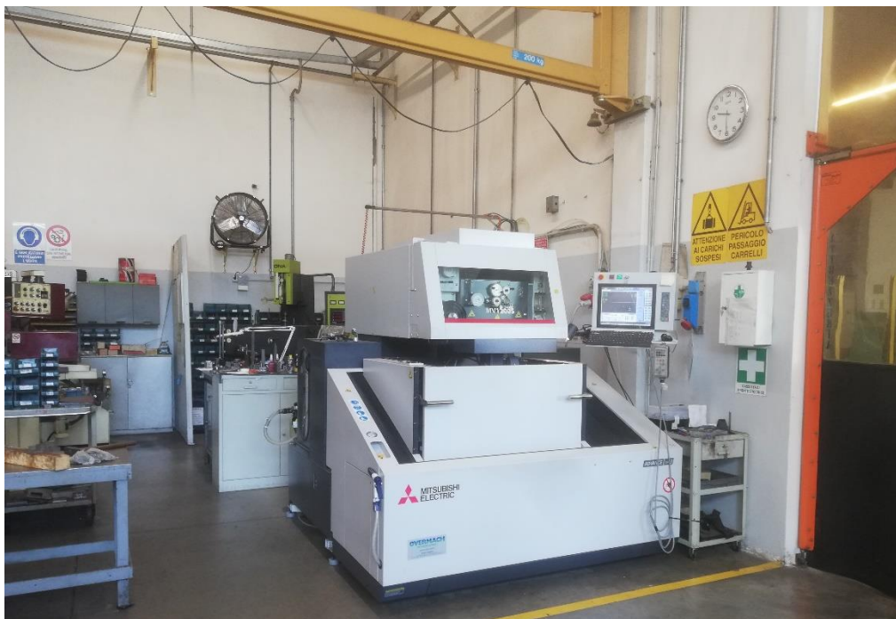
Vista frontale del bene installato in Azienda
